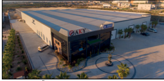
Üretim ve Montaj Fabrikası - Production and Assembly Factory
